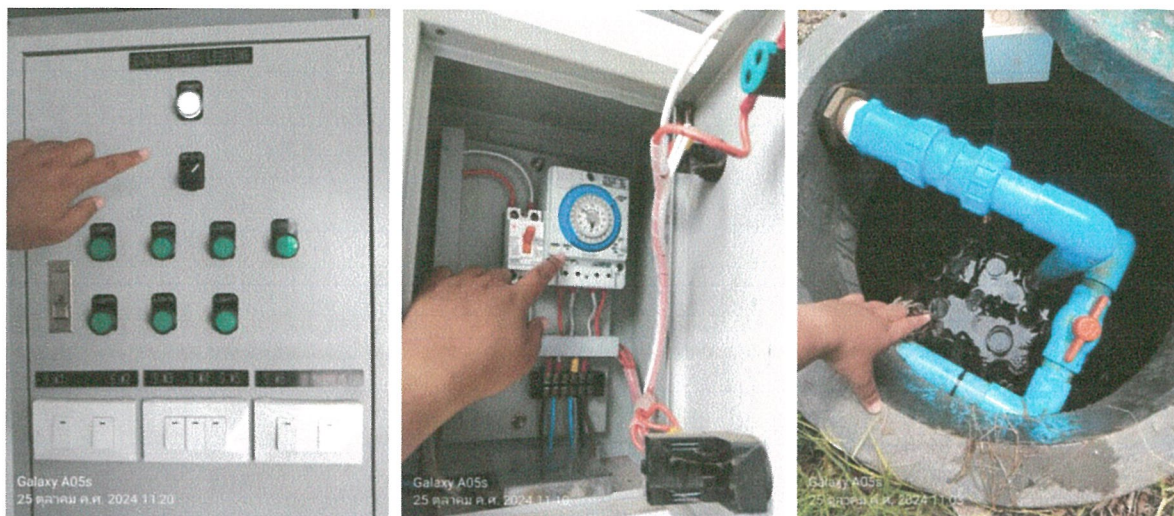
รูปภาพที่ 2.8 การตรวจสอบการทำงานของระบบบำบัดน้ำเสีย
